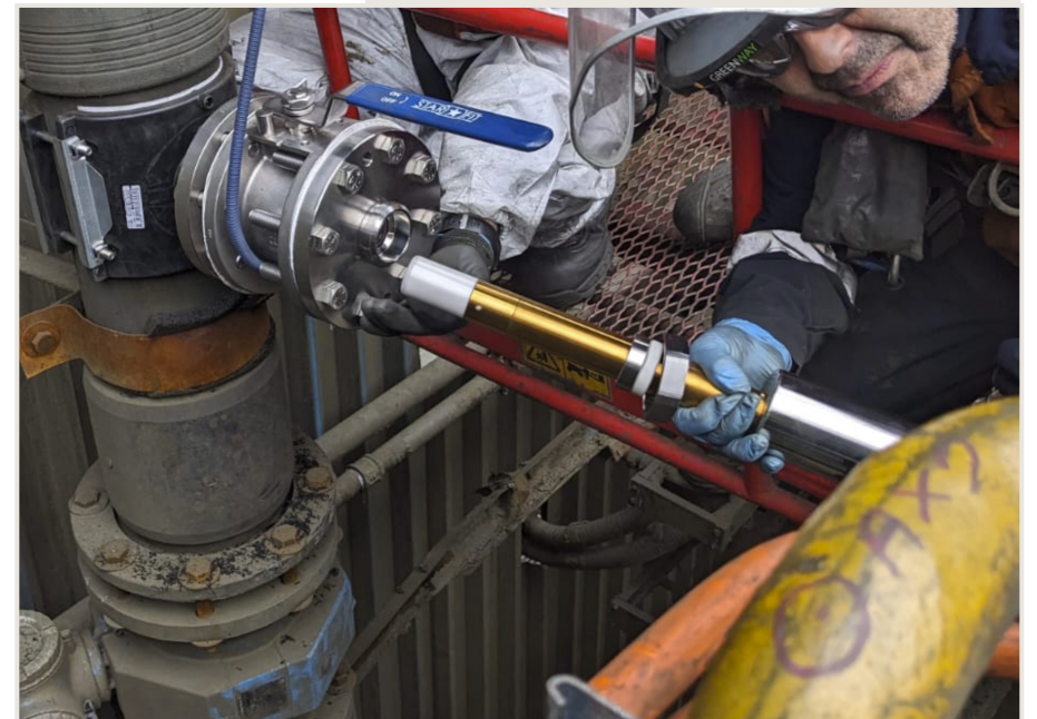
Seção tipo T com hot-tap
